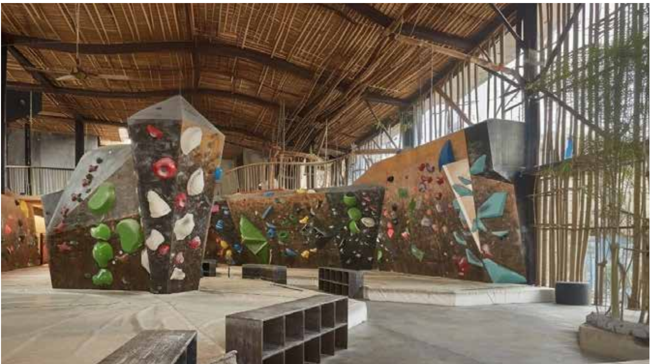
Die Boulderhalle besteht aus einer Hülle aus lokalen nachhaltigen Materialien und Kletterwandelementen aus mehrschichtigen Seekieferplatten.
