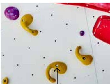
Vorderseite der Wand: Griffe, befestigt mit M10 Gewindeschrauben
