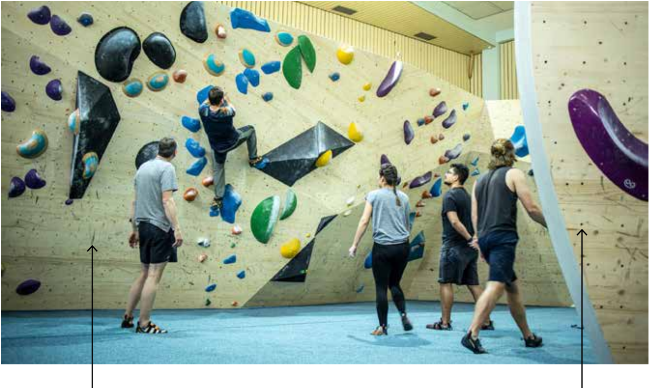
Holzplatten aus Seekiefer, Rohformat 2 x 5 Meter, 7-lagig, 20 mm dick
